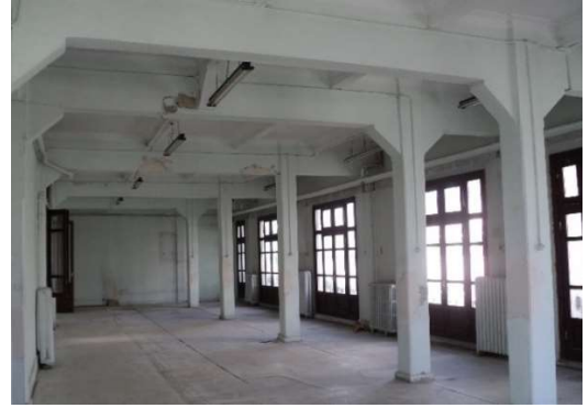
Şekil 12. Çinili Han taşıyıcı sistem görünüşü
