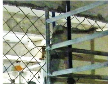
Şekil 6. Betonarme perde donatıları
