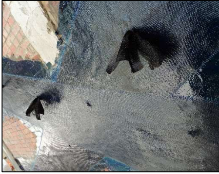
Şekil 17. Ankraj Uygulama Detayı
