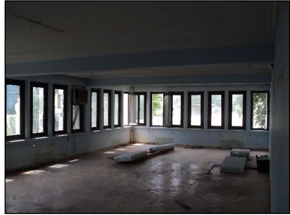
Şekil 2. Yapının İçten Görünüşü
