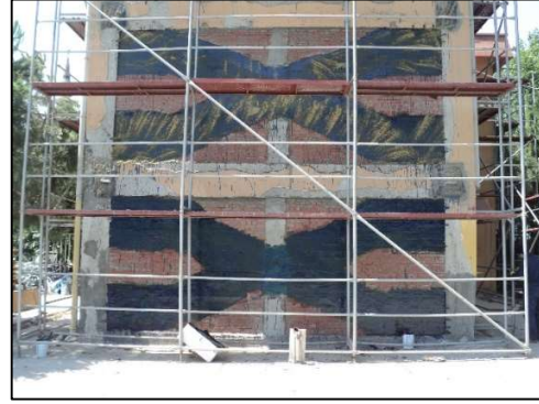
Şekil 16. Yapılan Uygulama – Kısa Doğrultu
