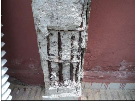
Şekil 3. Mevcut Kolon Sıyırması
