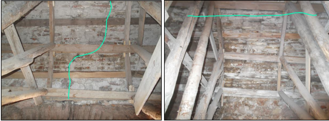
Şekil 3 Tonoz Üzerinde Tespit Edilen Çatlak Hasarı Fotoğrafları
